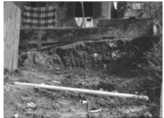
Tubulação hidráulica aparente e enfraquecimento do talude
